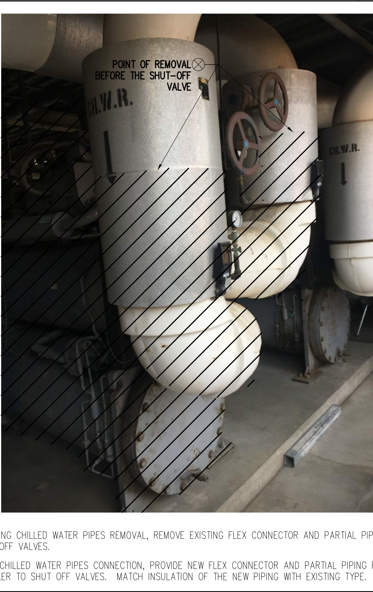
POR & POC FOR CHILLED WATER PIPES SCALE: NONE 2
